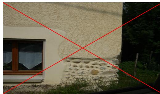
*Des finitions d'enduit interdites car en saillie ou découvrant le soubassement.*
