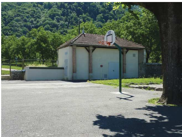
Une reconversion inattendue d'un préau en chaufferie bois
