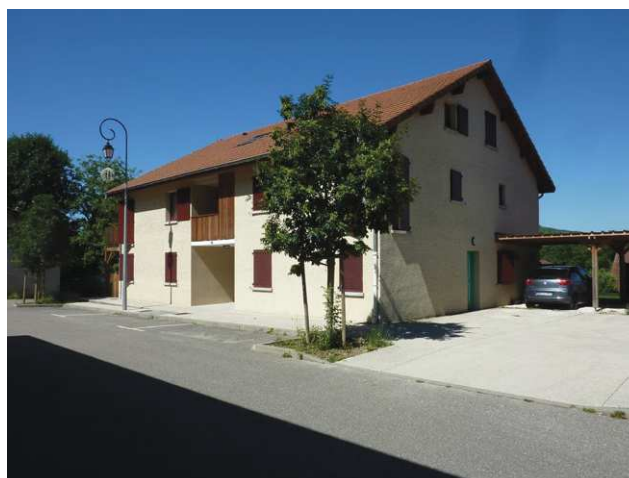
Un logement collectif récent dans la volumétrie d'une ancienne ferme agricole
