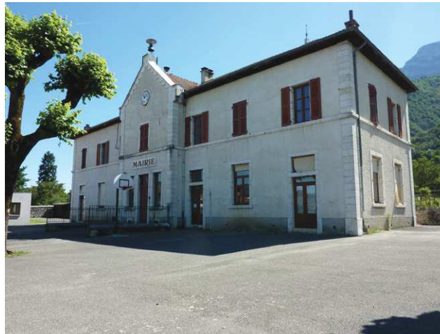
La mairie avec un logement à l'étage dont le parvis et l'articulation à l'espace public pourrait être améliorés
