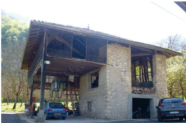
Séchoir mixte, restauré et utilisé pour un usage domestique, situé à l'entrée du hameau de Lignet.
